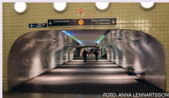
Lång tunnel vid Jakobsbergs tunnelbanestation.
